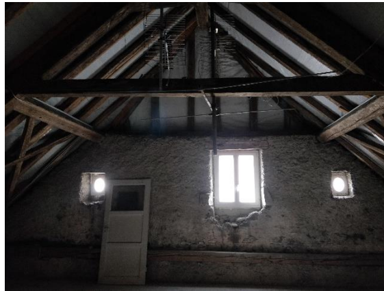
Combles non-isolés et peu exploités
